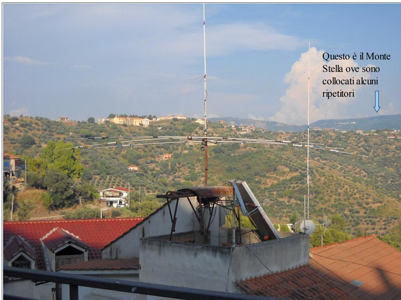
Si nota una bella direttiva per le HF con rispettivo rotore e due verticali per le VHF/UHF. Non ci giurerei, ma presumo che si tratti del carissimo Costabile IK8JLY che collegai due volte sul Link Nazionale (d'invero!!) e che non ascolto da molto tempo. Mi ero ripromesso di andarlo a trovare presso il proprio QRL, ma dato l'esiguo numero di giorni di soggiorno che avevo a disposizione, ho abbandonato l'idea.
